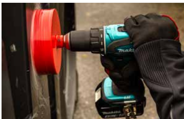
Vrtací korunkou vytvoříte otvor u dna nádrže pro připojení regulovaného odtoku
