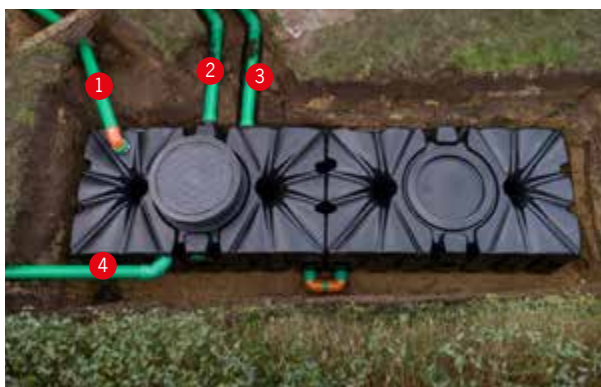
Příklad návrhu nádrže 4 000 l použité pro retenci dešťové vody
