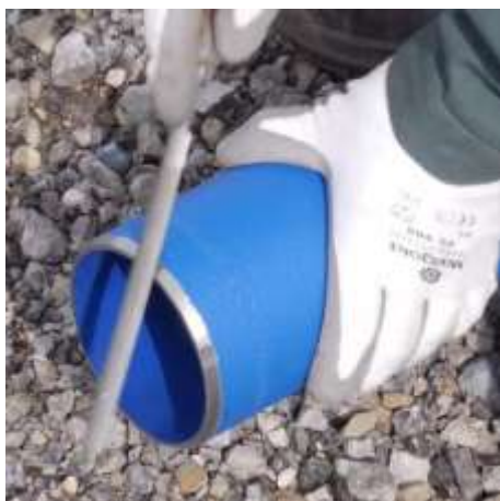
Zaoblení ostré hrany pomocí pilníku
