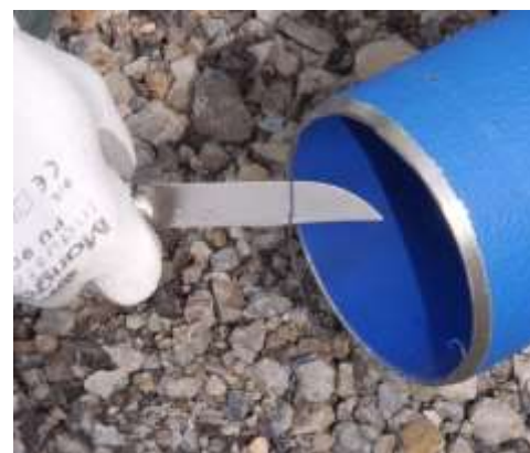
Oříznuti Ductanu v místě řezu
